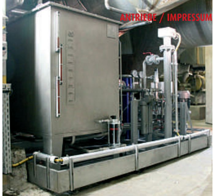
Zentralschmieranlage Lubriflex® zur Versorgung des GearClones
