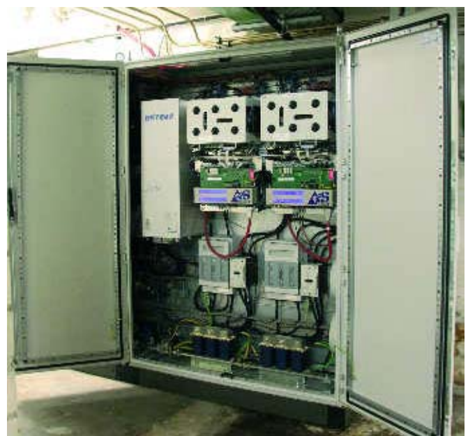
Abb. 8: AS-Frequenzumformer PM/PD Converter 1000 – Erster von AS gebauter Papiermaschinen-Profi-Drive-Converter
