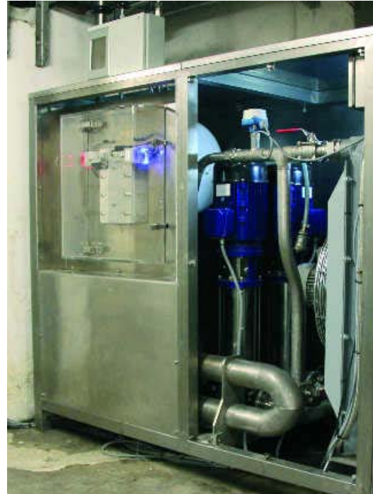
Abb. 6: Kühlwasseraggregat Cooliflex® mit Regelungsorgan FlexiFlow® Water
