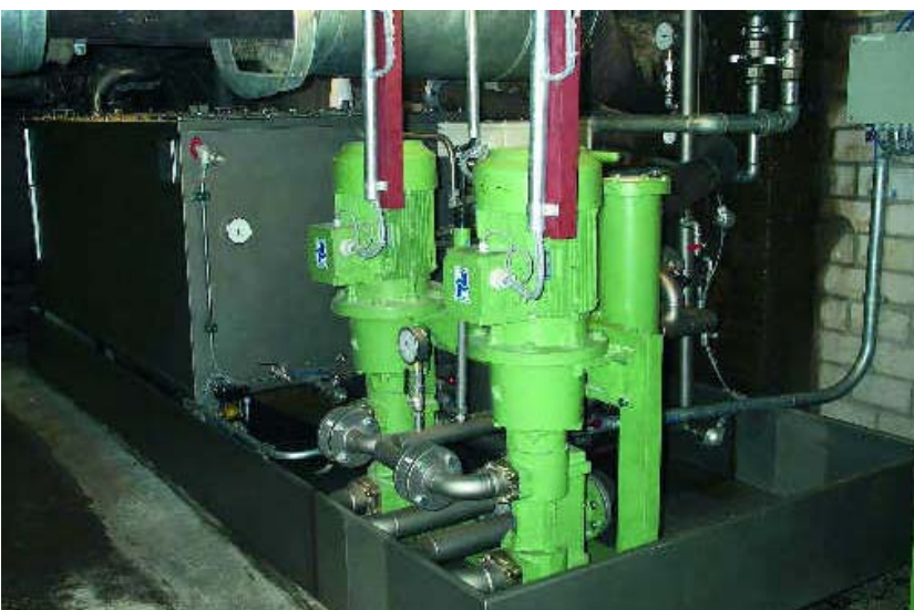
Abb. 1: Öl-Umlaufschmieranlage Lubriflex® Bj. 2004
