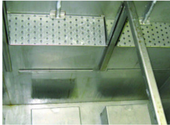
Abb. 4 und 5: Im Tank vor und nach der Reinigung
