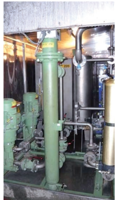
Lubriflex Mini Größe III mit 1000 l mit Dacheinhauung im Nassteil.
